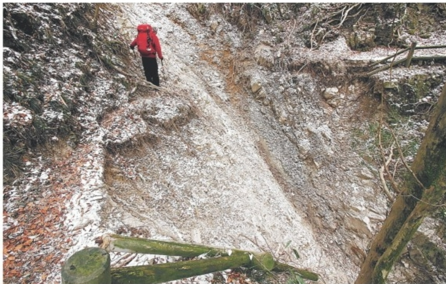
七曲滝へ向かう登山道。がけが崩落し、寸断されている。神戸市北区有馬町
